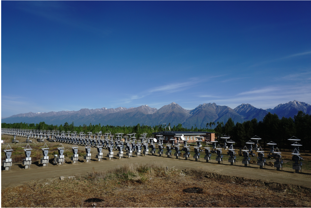
Рис. 1. Общий вид Сибирского радиогелиографа. Три Т-образных антенных решетки содержат антенны с диаметрами 1, 2 и 3 м. Соответствующие диапазоны рабочих частот 12–24, 6–12, 3–6 ГГц.
